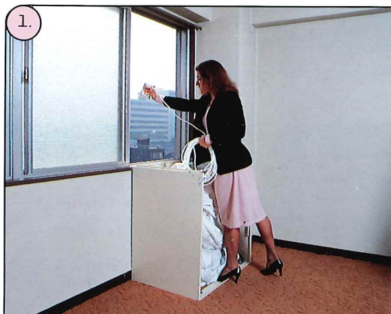
1. キャビネットを取除き、誘導綱を投下して、
